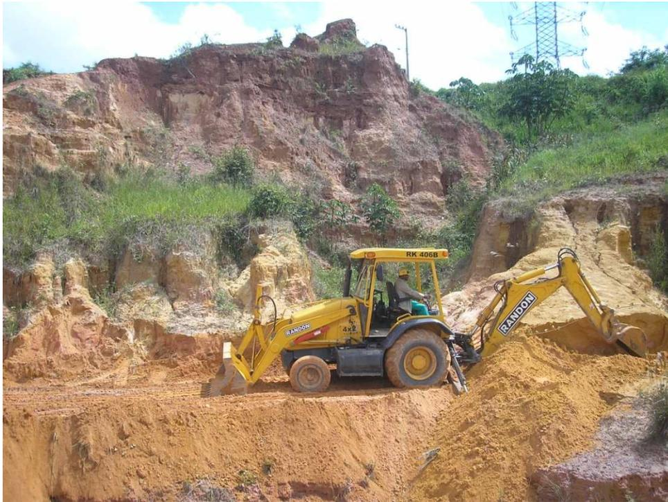
Figura 21 – Retaludamento da área com retroescavadeira. Foto: Bezerra, 2008.
