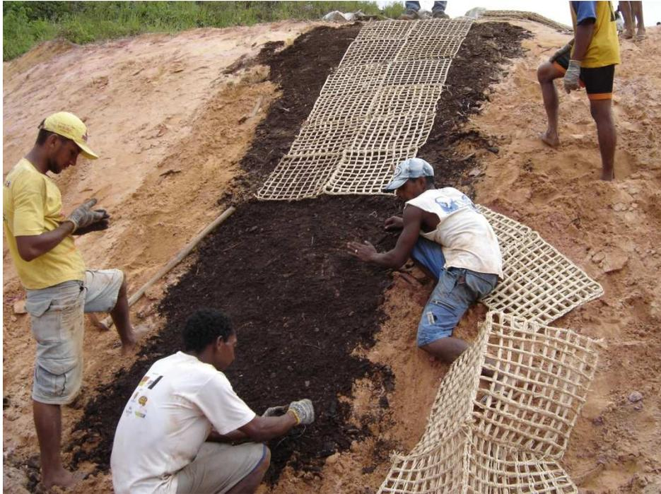
Figura 23 – Aplicação dos geotêxteis e insumos. Foto: Bezerra, 2008.
