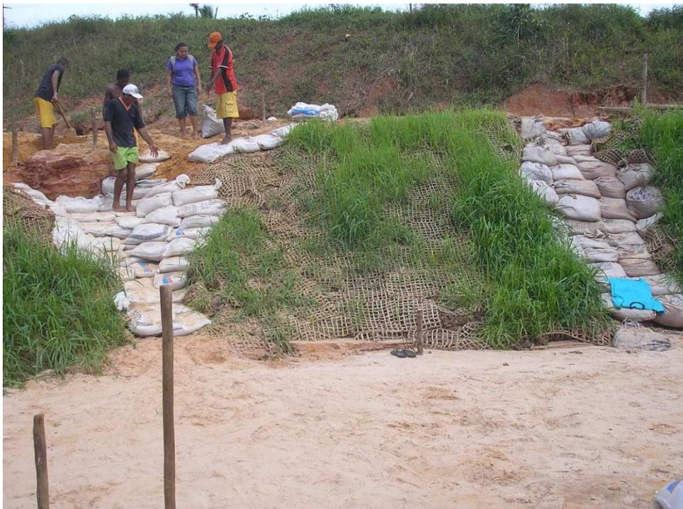
Figura 24 – Manutenção dos trabalhos de reabilitação. Foto: Bezerra, 2008.
