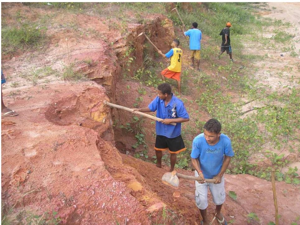
Figura 22 – Retaludamento com trabalho manual. Foto: Bezerra, 2008.
