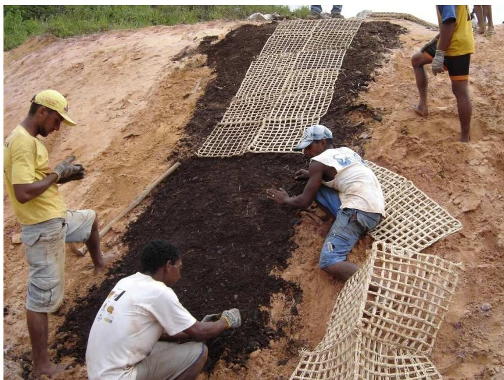
Figura 107 – Aplicação dos geotêxteis e insumos.
